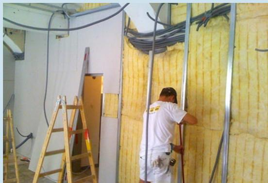
Wände und Decke wurden isoliert und verkleidet.
